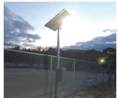
学校に設置された自立式の太陽光パネル&LED電気・蓄電池
