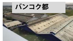
バンコク都 工場屋上を利用した太陽光発電およびEMS（ファインテック）
